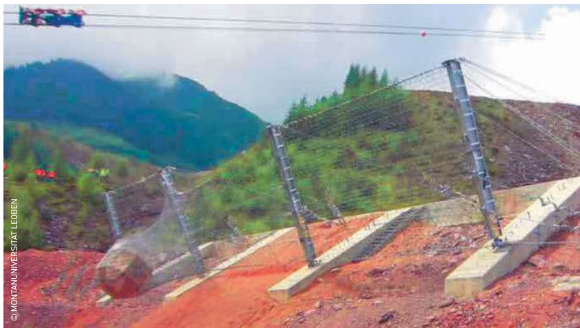
Prüfung des Steinschlagschutzsystems TSC-3000-ZD der TRUMER Schutzbauten Ges.m.b.H.
